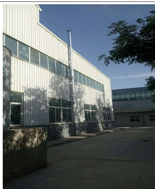
防水灰浆生产线 15m 排气筒
