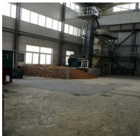
干砂储存围挡
